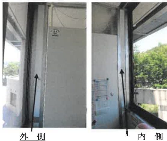
<電話相談室の防音施工>
